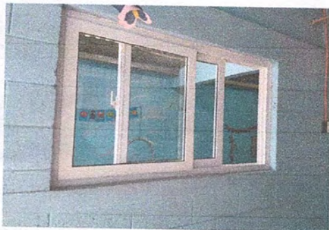
Foto 3: COLOCACIÓN DE VENTANAS.
