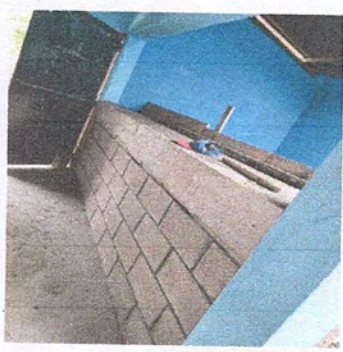
Foto 1: Finalización de muro medianero
