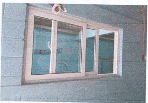
Foto 3: colocación de ventanas
