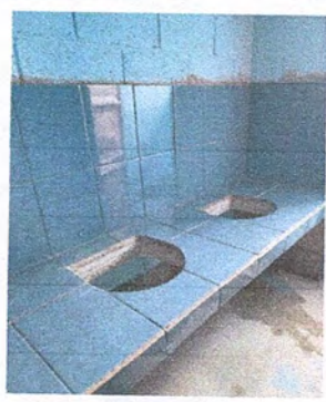
Foto 2: Colocación de azulejos para lava manos
